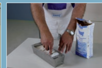
6. Rozmíchání sádrového tmelu Knauf Uniflott
