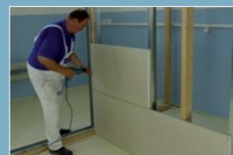
4. Montáž desek se provádí naležato
