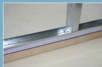
1. Osazení UW profilů na podlahu
