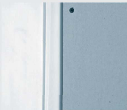
4. Sadrokartónovú dosku montovať vo vzdialenosti od steny 5 mm
