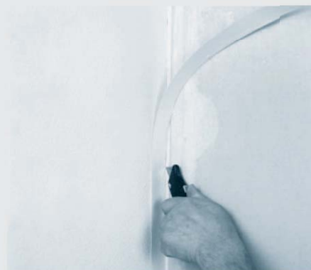
6. Po vytvrdnutí sadrového tmelu odrezať prečnievajúcu pásku
