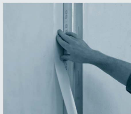
3. Alternatívne je možné Knauf Trenn-Fix nalepiť aj na priliehajúcu konštrukciu po montáži profilu
