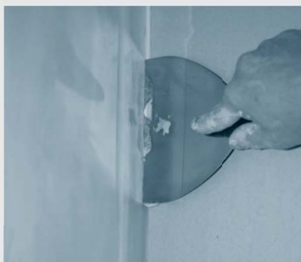
5. Po montáži dosiek previesť tmelenie sadrovým tmelom
