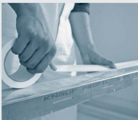
1. Prítlačte samolepiacu stranu páske Knauf Trenn-Fix na CW/UW Profil
