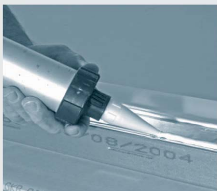
2. Naneste tmel Knauf Trennwandkitt na utesnenie napojenia
