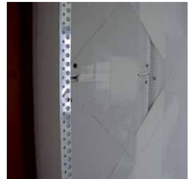
Tmelení hrany HRAK se samolepící páskou (svislá), příčné hrany se skelnou páskou a použití ochrany rohů
