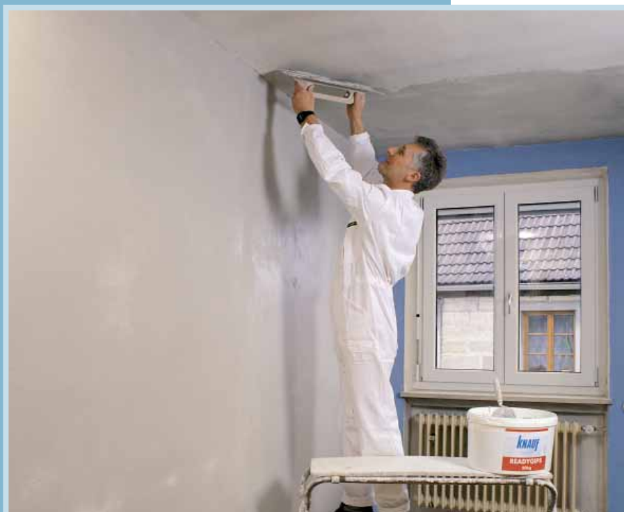
Nejprve se Multi-Finish natáhne na stěnu či strop nerezovým hladítkem
