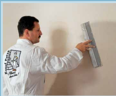
...a po cca dalších pěti minutách se vyhladí (utáhne) nerezovým hladítkem nebo motýlovým hladítkem
