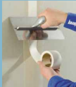
Vložení papírové pásky do sádrového tmelu
