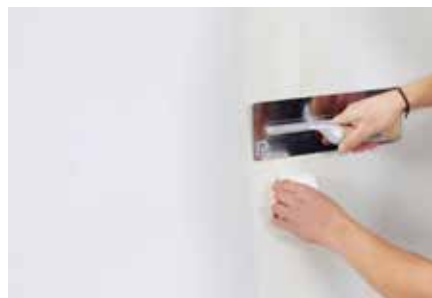
03 | Vtlačenie pásky do tmelu Sklovláknitá výstužná páska sa vtlačí do tmelu čistým hladidlom. Pred ďalšími povrchovými úpravami sa nechá tmel zaschnúť.
