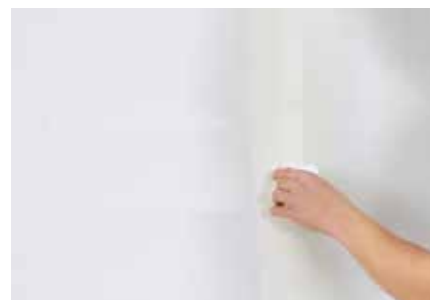
02 | Výstužná páska Do vrstvy tmelu sa rolovaním vloží vonkajšou stranou sklovláknitá výstužná páska.
