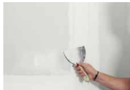
04 | Odstránenie nerovností Z povrchu pretmeleného spoja so zapracovanou výstužnou páskou sa nerovnosti odstránia ocelovou špachtľou.
