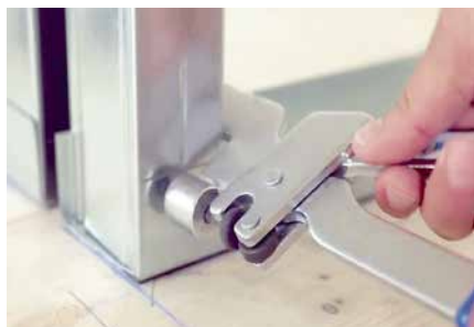
21 | Spoj CW a UW profilu Na mieste rohu sa osadí ukončovací profil CW presne na hranu profilu UW. Proti vypadnutiu sa CW profil spojí s profilom UW krimpovacími kliešťami na spájanie profilov. Profily sa spoja aj v hornej časti pod stropom.
