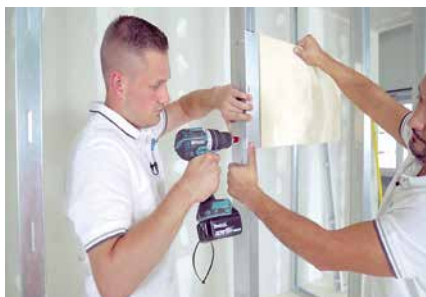
22 | Univerzálna traverza Na vystuženie steny sa namontuje medzi stojky podkonštrukcie univerzálna traverza. Z univerzálnej traverzy sa vyberie montážna balenie. Označí sa montážna výška a traverza sa priskrutkuje cez predpripravené otvory na stojky.
