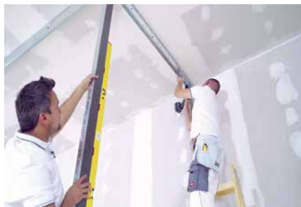
18 | Kratšia strana priečky Rovnako sa pripevní profil UW na kratšej strane priečky. Do profilu UW sa v mieste rohu vloží profil CW. Pri montáži treba dbať na jeho zvislosť.
