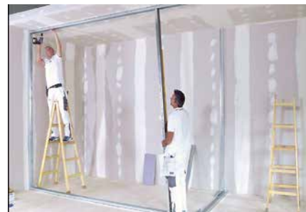
17 | Pripevnenie profilov do stropu Profily skrátené na požadovaný rozmer sa pripevnia univerzálnymi skrutkami presne podľa vyznačenej línie do stropnej konštrukcie.
