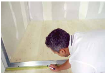
19 | Raster pre zvislé stojky Po pripevnení profilov do podlahy, na steny a do stropnej konštrukcie sa rozmeria raster pre zvislé profily, ktoré budú tvoriť podkonštrukciu pod sadrokartónové dosky. Osová vzdialenosť medzi stojkami má byť 600 až 625 mm.
