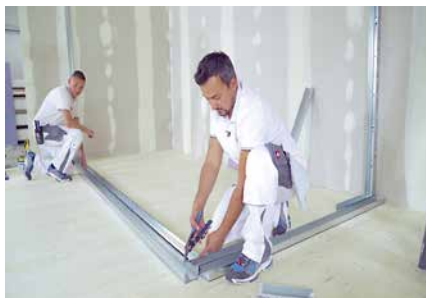
16 | Stropné profily Profily UW sa skrátia na požadovaný rozmer. Dĺžka priečného profilu na kratšej strane priečky má byť o 10 mm kratšia. Dĺžka pozdĺžneho profilu na dlhšej strane priečky o 20 mm.
