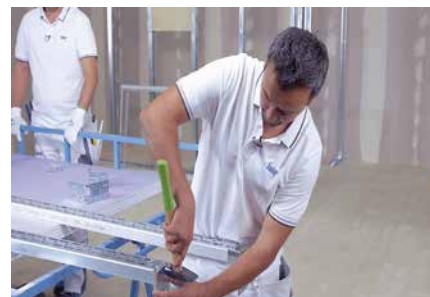
23 | Profily UA a montážne uholníky Profil UA sa skráti uhlovou brúskou na požadovanú dĺžku (o 50 mm kratšie ako CW profily). A na konce profilov sa zastrčia montážne uholníky. Montážny uholník bez otvoru sa upevňuje do podlahy a s otvorom do stropu.
